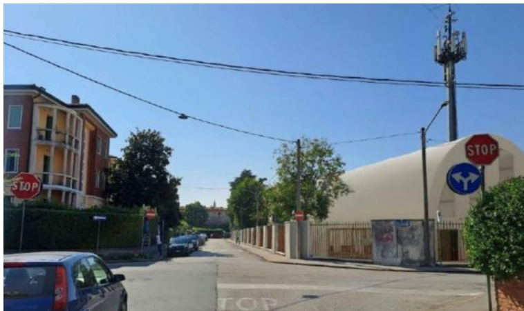
L'impianto Uno dei risultati dello studio dell'impatto scenico-percettivo dell'intervento da circa 250 mila euro
